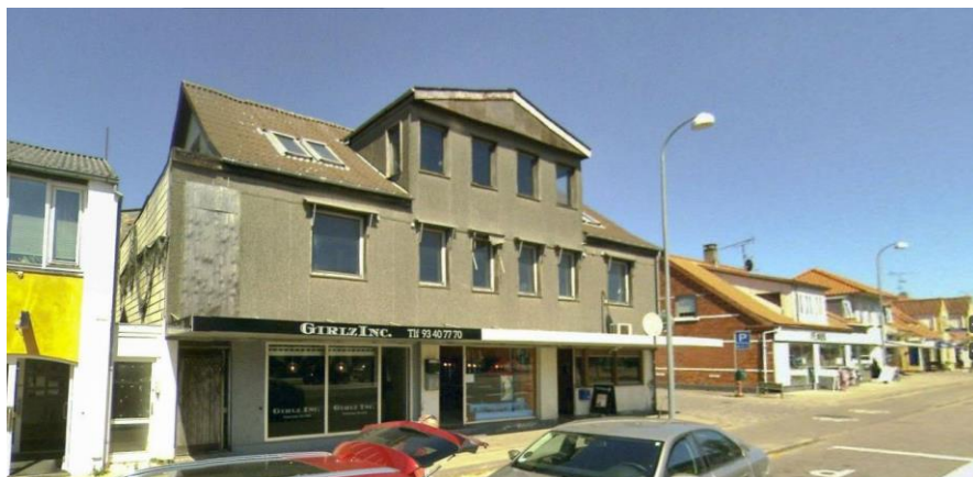
Eksisterende bygning ud mod Hovedgaden.
